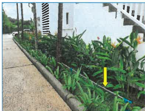
ท่อน้ำสำหรับรดน้ำต้นไม้
