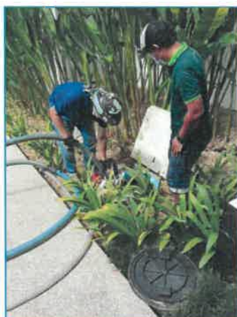
ภาพถ่ายที่ 2.2-19 การสูบน้ำในถังเกรอะ
