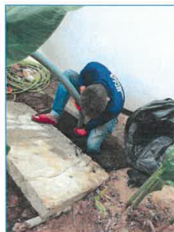
ภาพถ่ายที่ 2.2-19 การสูบน้ำในถังเกรอะ
